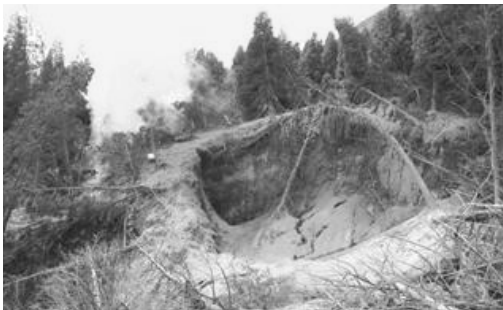
写真 2 2007 年 5 月 12 日の b1 跡および b2 噴気孔 b1 噴気孔が閉塞して、西側に新たな b2 噴気孔 (写真左側)が生じた。
